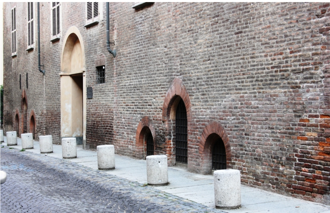
Fig. 15 : ASTI (Piémont) : palazzo Zoya, via G. Carducci 65, xiii e siècle. De part et d'autre du large portail, grande porte conduisant à de vastes caves voûtées.
