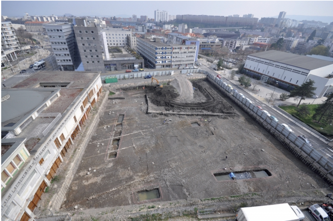
Figure 1 : vue aérienne du site en cours de fouille.
