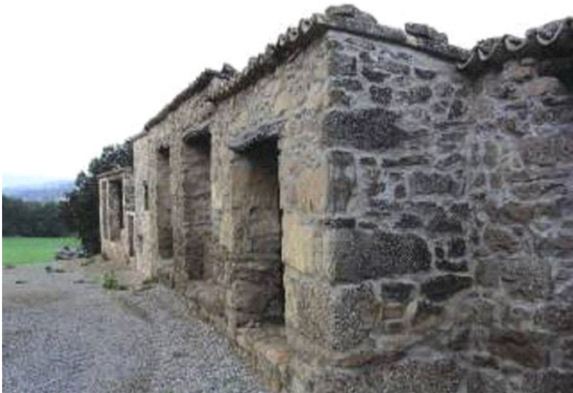
Rangées de tinas à côté du mas Serra de Fals (centre de la Catalogne) construites en 1850 (photo livre E. Molins)
