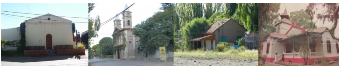
Fig. 8. Patrimonio arquitectónico, distrito Lunlunta: Bodega Domain St. Diego; Estación FFCC; y viviendas.
