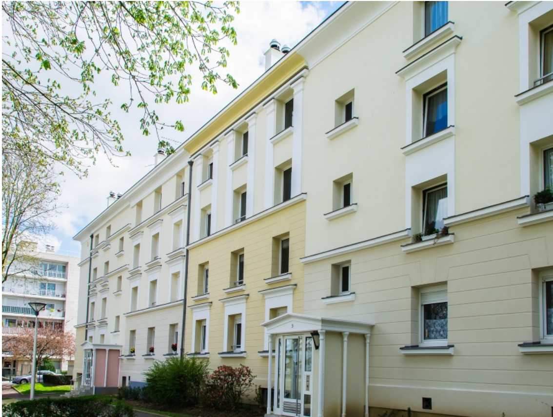
Figure 4. Une barre_rhabillée_au Plessis-Robinson.
