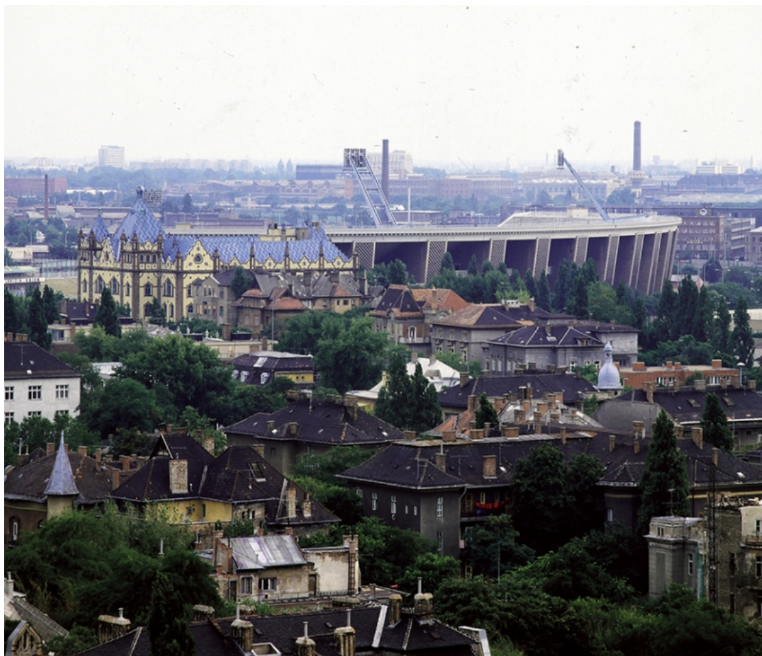
Figure n° 3. Le Népstadion dans son environnement urbain à la fin de l'ère communiste (1987).
