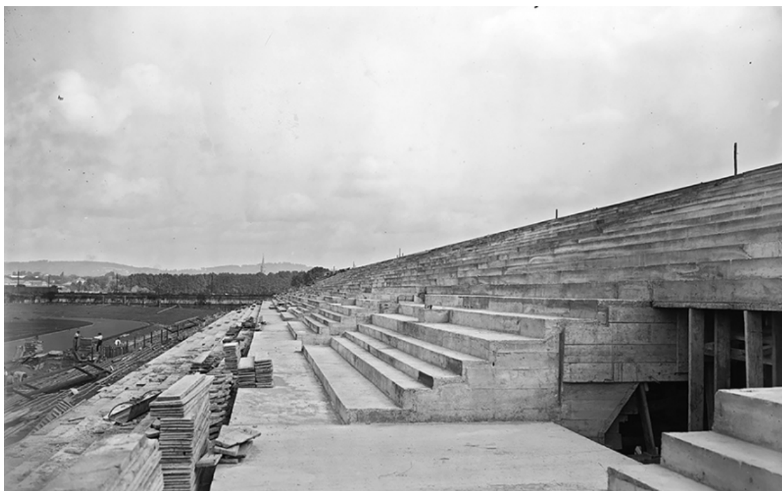
Figure n°1. Construction des tribunes du stade de Colombes, 23 août 1923.
